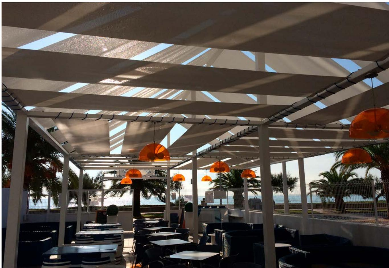
Estructura lonas microperforadas
